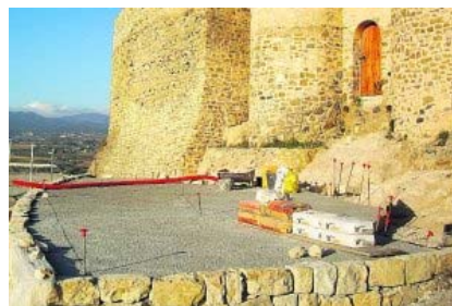
Material de obra en la escalinata a medio construir. :: R. B.
