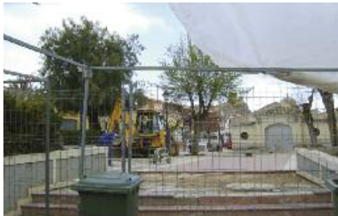
Obras en la plaza de España.
