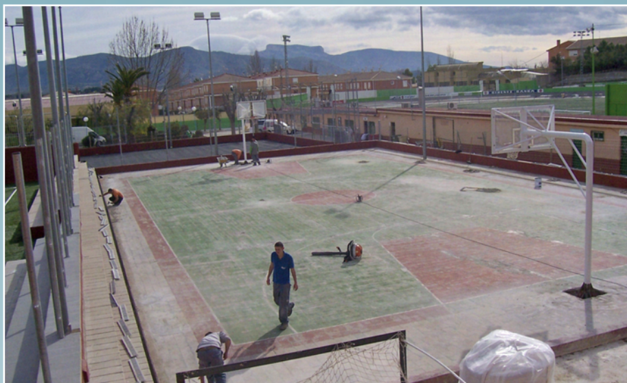
Una de las pistas que están siendo remodeladas en la Ciudad Deportiva.
