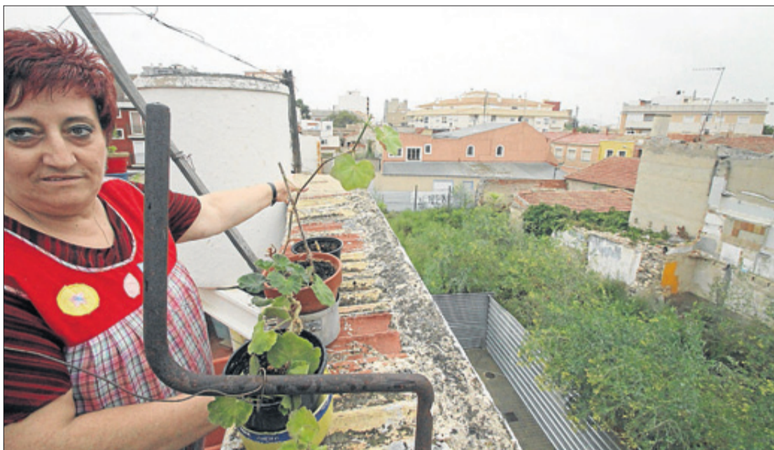
Los solares abandonados en la zona se han convertido en un foco de infección para los vecinos. JESÚS CRUCES
