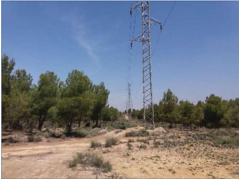
Imagen 80. Imagen de línea eléctrica con conductores desnudos y tratamiento de la vegetación, en la zona del Cabezo de los Conejos. Fuente: Medi XXI GSA.
